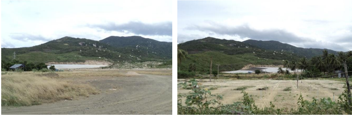
Hình 2-36. Bãi chứa Nix thải của Nhà máy HVS
